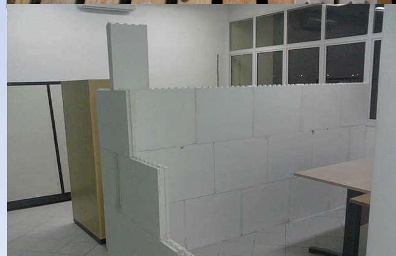
Bloquetes para execução de Paredes
