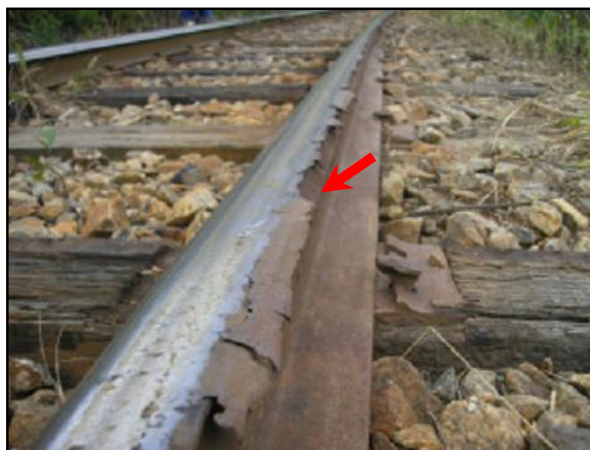
FIG. 4.17: Estilhamento do Canto da Bitola FONTE: FCA (2007, b)
