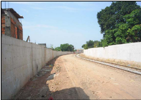
FIG. 5.4: Muro de Concreto FONTE: ANTF (2007, b)
