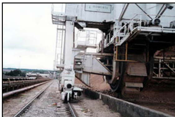
FIG. 5.9: Substituição de Dormentes FONTE: CONSTRENCE (2007, b)
