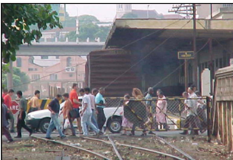
FIG. 5.3: Passagem em Nível Crítica (São José do Rio Preto/SP) FONTE: ANTF (2007, b)
