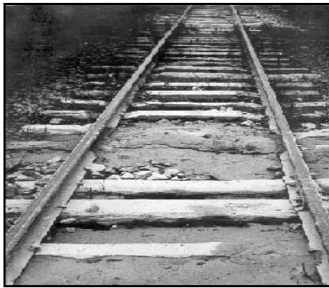
FIG. 4.35: Lastro Colmatado FONTE: ABGE, 2007
