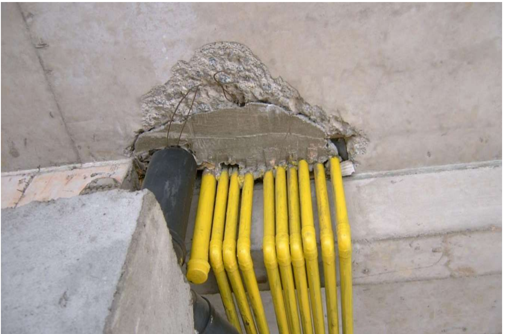
Detalhes da tubulação de gás
