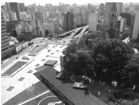
PISO CONCRETO PRAÇA ROOSEVELT
