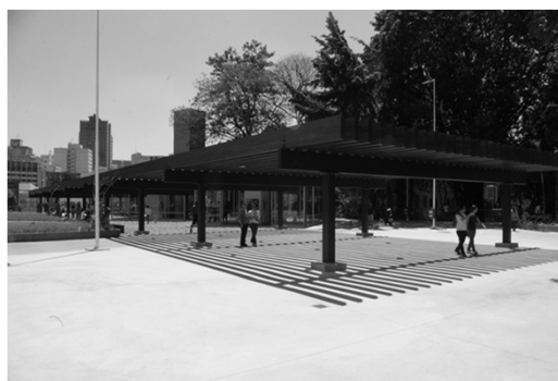
PISO CONCRETO PRAÇA ROOSEVELT
