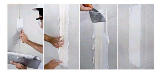
Nos ângulos internos dos encontros da parede utilize a mesma fita de rejuntar as chapas. Entretanto, nos ângulos externos das paredes, ou seja, na quina da parede pelo lado de fora, você deve utilizar uma cantoneira metálica de reforço (cantoneira perfurada). Esta deve ser afixada após a aplicação da primeira demão e coberta pela segunda e terceira demãos.
