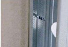
Importante: As chapas devem ser cortadas com 10mm (1,0cm) a menos, para facilitar o acabamento da parede.
