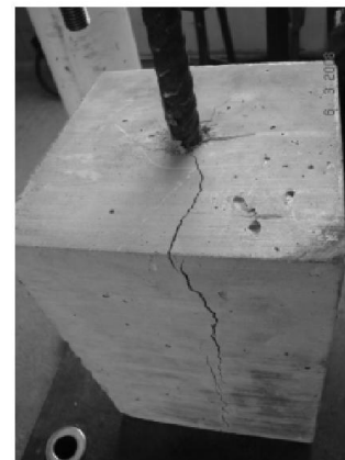
Vista superior de ruptura
