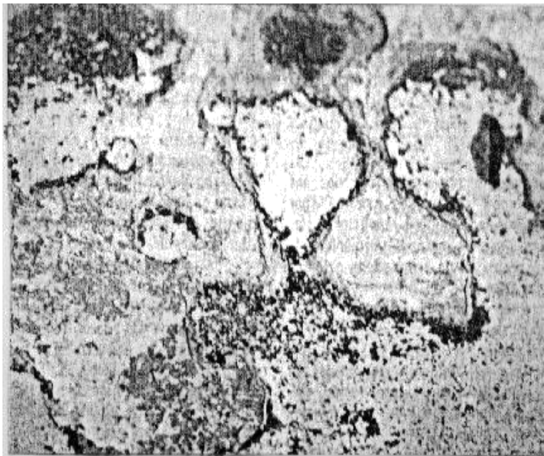
Figura 9.7 - Acúmulo de bolor no revestimento por efeito de umidade.
