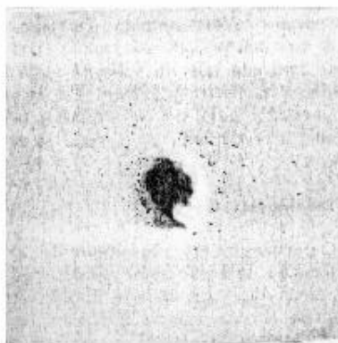
Figura 9.1 - Vesícula formada no reboco. No centro da vesícula, material pulverulento escuro.
