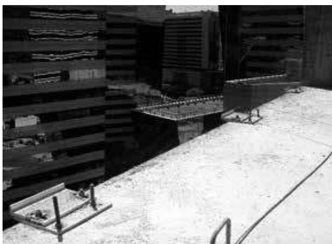
Figura 5.8 – Aspecto das ancoragens previamente fixadas na laje de concreto armado. (Acervo INOVATEC CONSULTORES)
