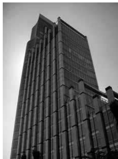
Figura 5.13 – Edifício BankBoston, em São Paulo. (Acervo Inovatec Consultores)
