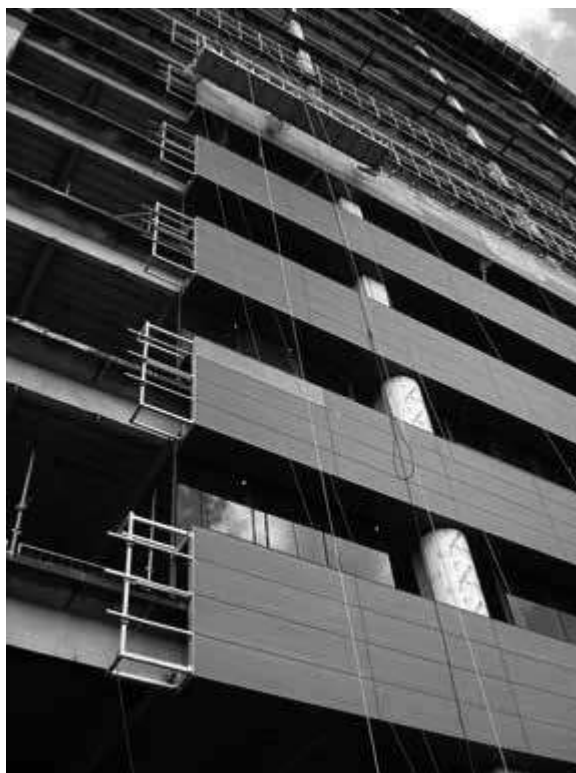
Figura 6.4 – Revestimento de painéis de laminado melamínico sendo aplicado em edifício com estrutura de aço. (acervo CODEME)
