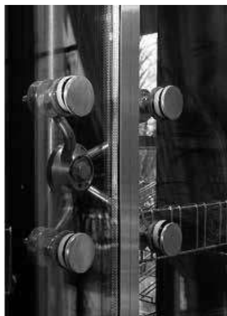
Figura 5.16 – Dispositivo de fixação do sistema spider glass . Neste tipo o vidro já é considerado um elemento estrutural da solução. (PORTAL METÁLICA, 2013b)
