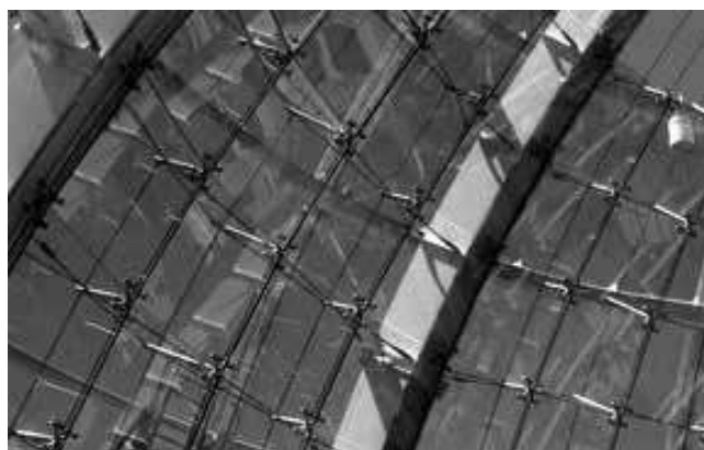
Figura 5.15 – San Jose Civic Center. Fachada com sistema Spider Glass para fixação de vidros. (PATTERSON, 2011)
