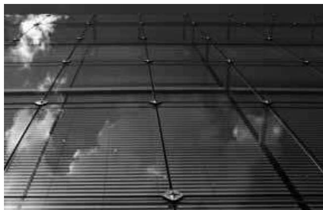
Figura 5.19 – Edifício da Loyola University, em Chicago. Fachada com sistema de fixação para vidros tipo point-fixed-clamped . (PATTERSON, 2011)
