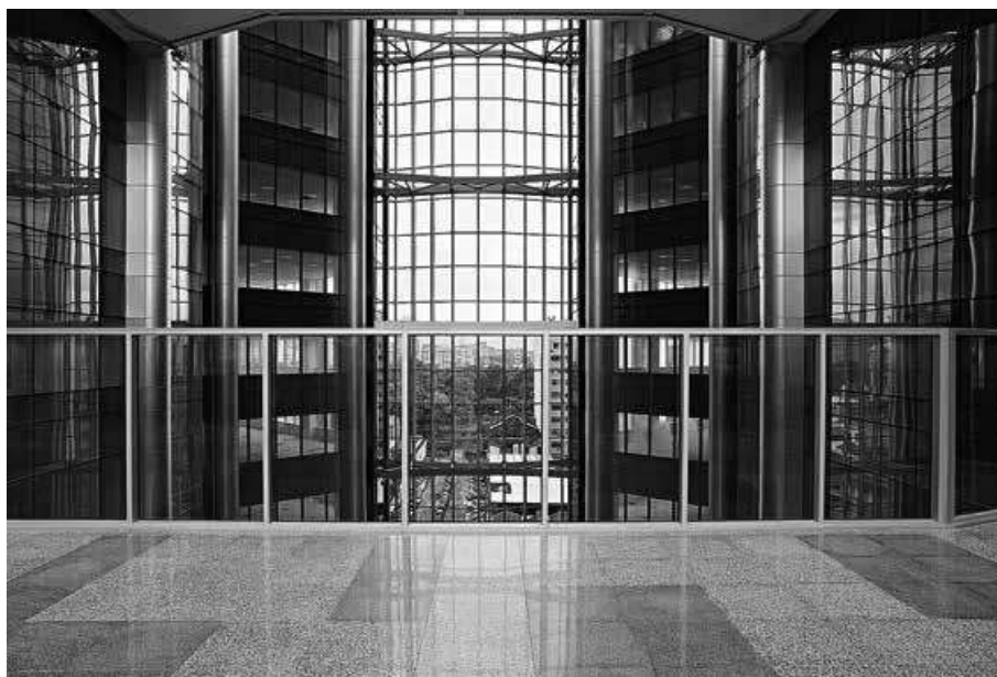
Figura 5.41 – Átrio do Centro Empresarial Senado. Destaque à fachada externa, executada pelo método de montagem Stick. (GELINSKI, 2013a)
