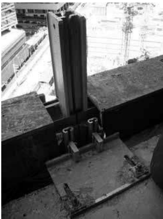
Figura 5.11 – Módulo em sua posição final. Destaque para a extensão das colunas para fixação do módulo superior. (Acervo INOVATEC CONSULTORES)
