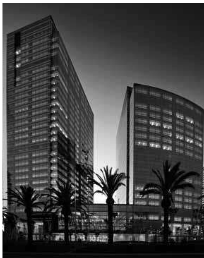
Figura 5.7 – Complexo Morumbi Corporate, em São Paulo. Estrutura mista em aço e concreto com fachada de vidro unitizada. (MEDEIROS, 2013)
