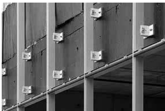
Figura 5.5 – Ancoragens, colunas e travessas instaladas. (FINESTRA, 2013a)
