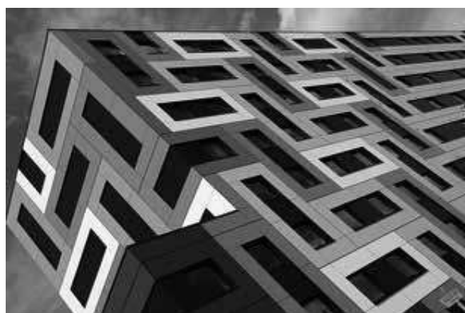
Figura 6.5 – Fachada revestida com painéis decorativos de laminado melamínica. (TRESPA, 2014)
