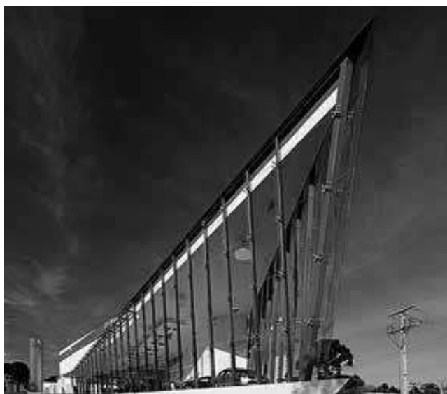
Figura 5.18 – Fachada em spyder glass de uma concessionária de automóvel. (SILVA, 2008)
