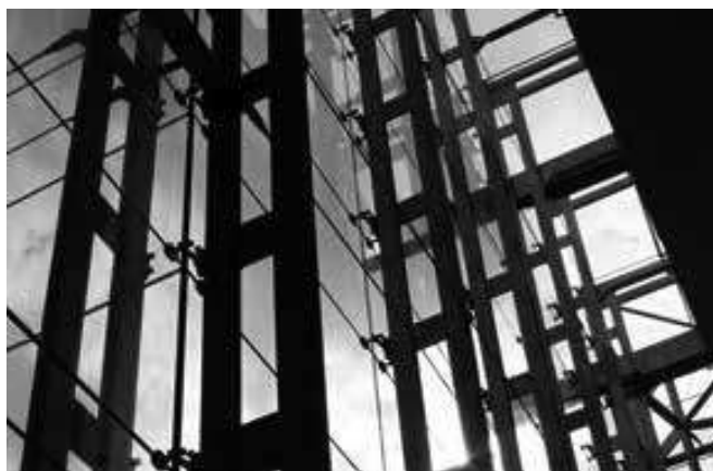
Figura 5.20 – Complexo L.A. Live Tower & Residences, em Los Angeles. Sistema de fachada com estrutura suporte treliçada. (PATTERSON, 2011)
