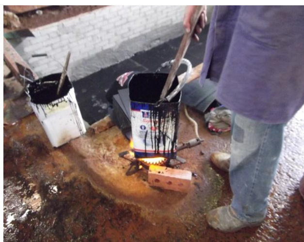
Figura 3 Impermeabilização com piche a quente
