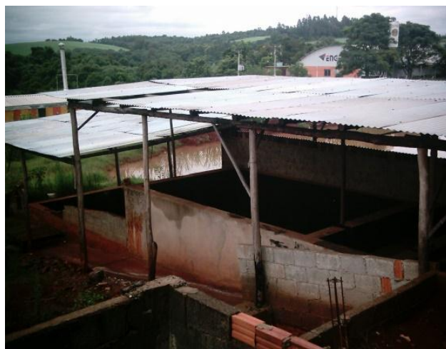
Figura 5 Estação de tratamento antes
