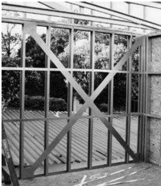
Foto 2 - Paineis com contraventamento em "X"
