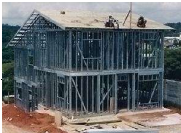
Foto 1 - Estrutura de residência em light steel frame
