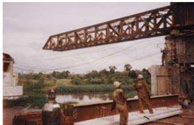
Figura 7.9 – Montagem de ponte por lançamento
