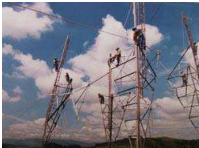
Figura 8.1 – Montagem de torre de transmissão de energia elétrica
