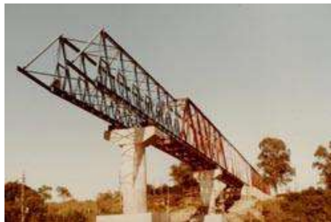
Figura 7.4 – Lançamento de ponte treliçada
