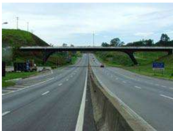
Figura 7.2 – Viaduto de pórtico rígido
