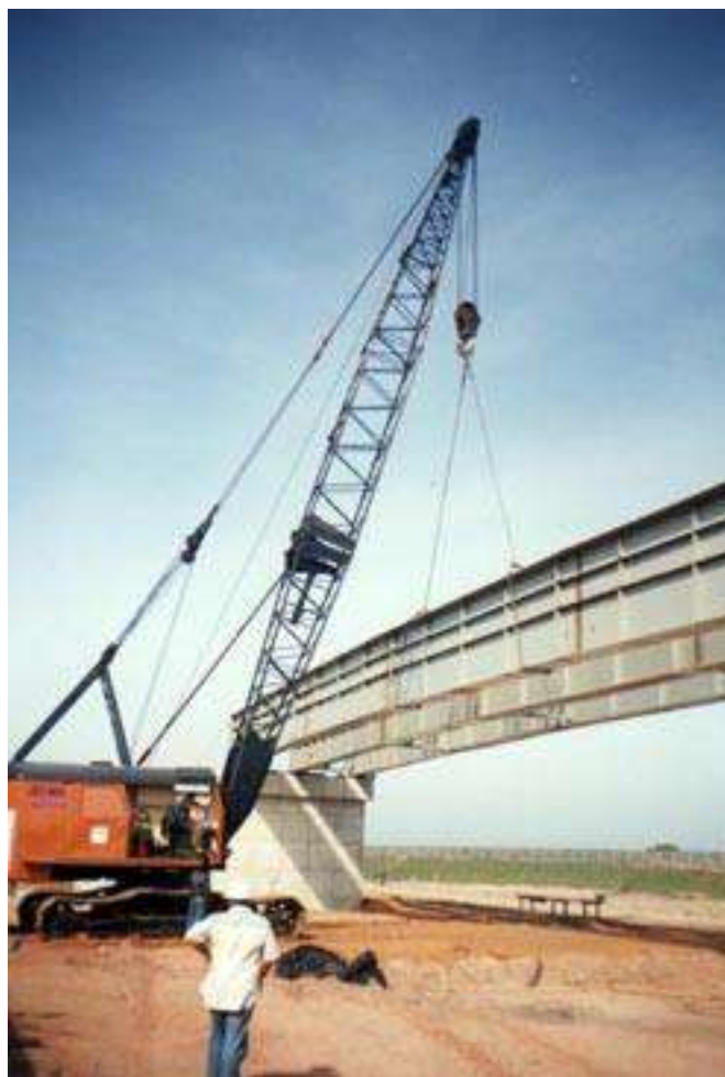
Figura 7.7 – Montagem pelo solo
