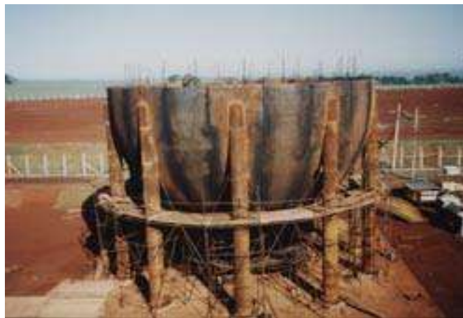
Figura 8.8 – Montagem de esfera de armazenamento
