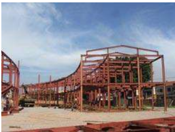
Figura 6.1 – Estrutura de Edifício em aço
