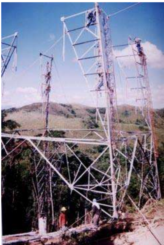
Figura 8.2 – Montagem de torre de transmissão de energia elétrica
