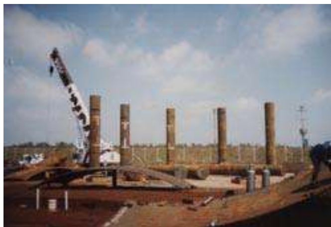
Figura 8.7 – Montagem de colunas de esfera de armazenamento
