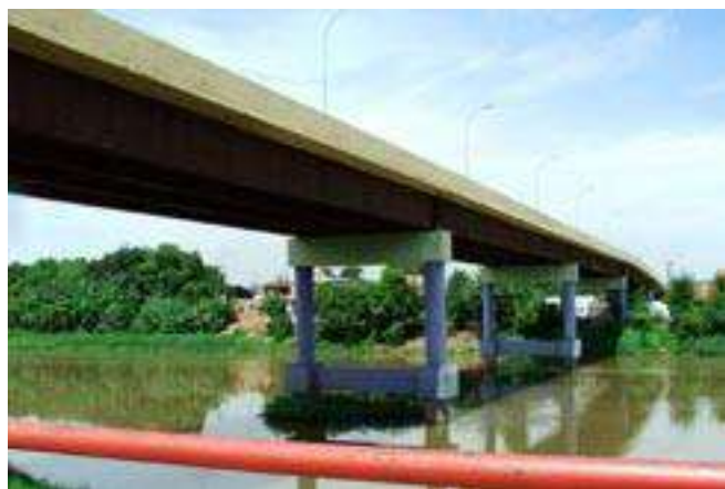
Figura 1.4 – Ponte em aço
