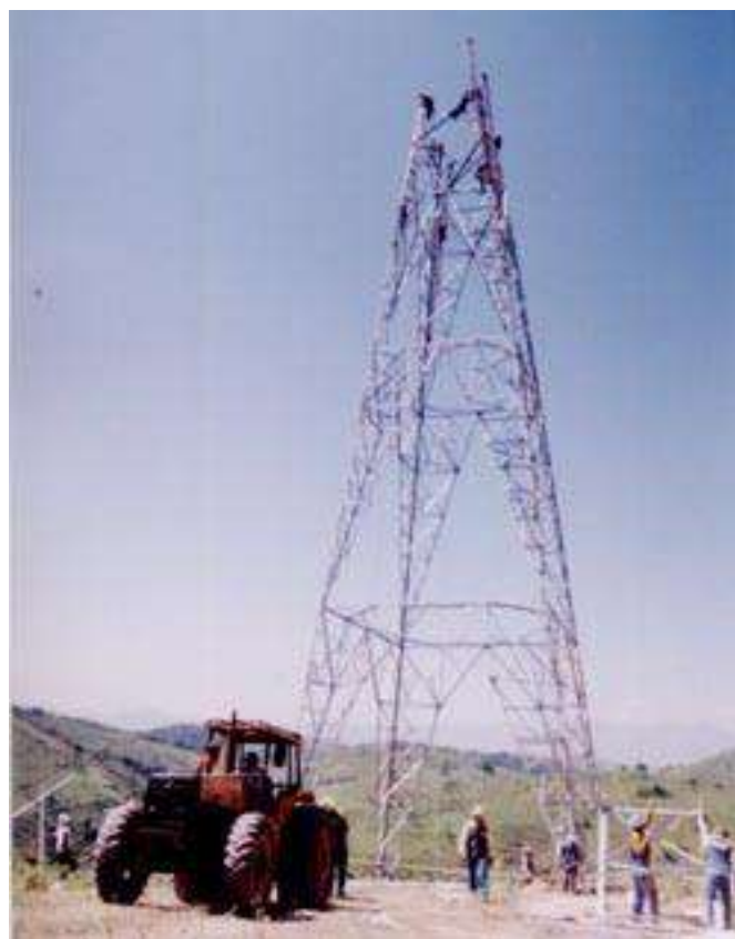
Figura 8.3 – Montagem de torre de transmissão de energia elétrica
