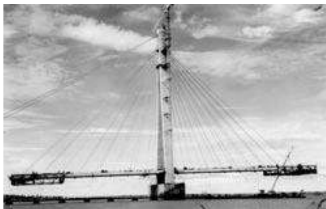
Figura 7.5 – Ponte estaiada em construção
