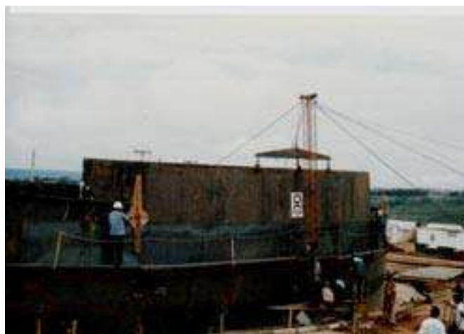
Figura 8.5 – Montagem de tanque de armazenamento
