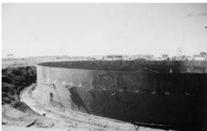
Figura 8.6 – Montagem de tanque de armazenamento
