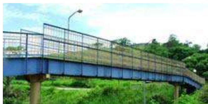
Figura 7.15 – Passarela de pedestres em aço
