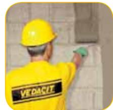
b) Aplicar 3 camadas de argamassa impermeável com 1 cm de espessura cada uma, intercaladas por um chapisco com **BIANCO**.
