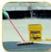
2) Subir a impermeabilização sem descontinuidade nos rodapés, beirais da laje e descer nos ralos.
