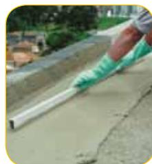
Conjunto de materiais que, uma vez aplicados, conferem impermeabilidade às construções. Existem basicamente dois sistemas: rígido e flexível.
