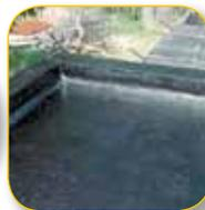
3) Após 24 horas, colocar a tela de poliéster **VEDATEX** em toda a superfície, com as abas perfeitamente aderidas. Fazer um transpasse de, no mínimo, 10 cm. A tela torna a membrana mais resistente aos esforços de tração e à punção. Em seguida, aplicar mais uma demão de **VEDAPREN**, sem diluição.
