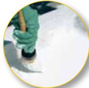
4) Subir a impermeabilização sem descontinuidade nos rodapés, beirais da laje e descer nos ralos.
