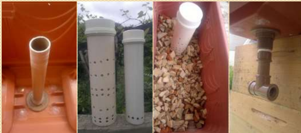
Figura 6 Estruturas formadoras do sifão.
