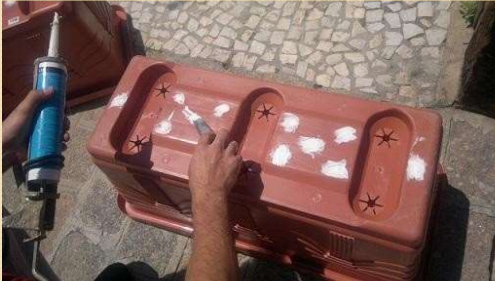
Figura 4 Fechamento dos orifícios nas bases das floreiras.
