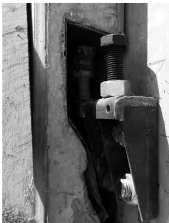
Figura 4.20 – Dispositivo com parafuso de regulagem de nível. (Acervo INOVATEC CONSULTORES)
