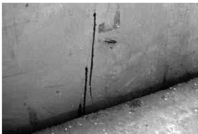
Figura 4.12 – Pannel pré-fabricado de concreto que apresentou fissura no sentido transversal a sua maior dimensão. Foi utilizada injeção de polímero na recuperação. (Acervo: Inovatec Consultores)
