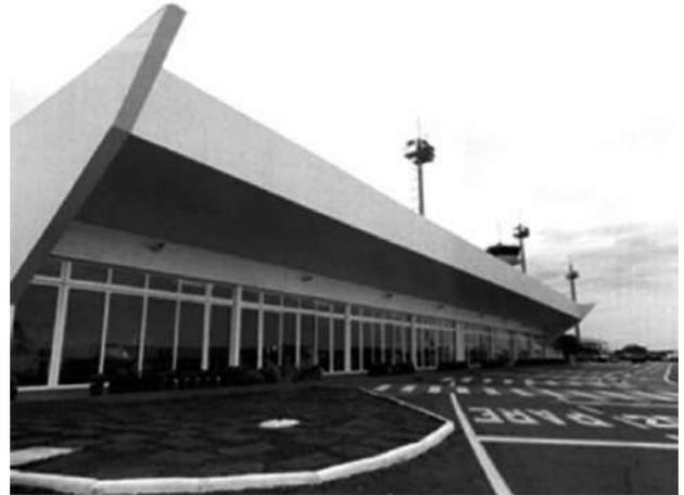
Figura 3.6 – Módulo operacional provisório instalado no aeroporto de Goiânia com fechamento em painéis metálicos isolantes. (FARIA & MARTINS, 2013).
