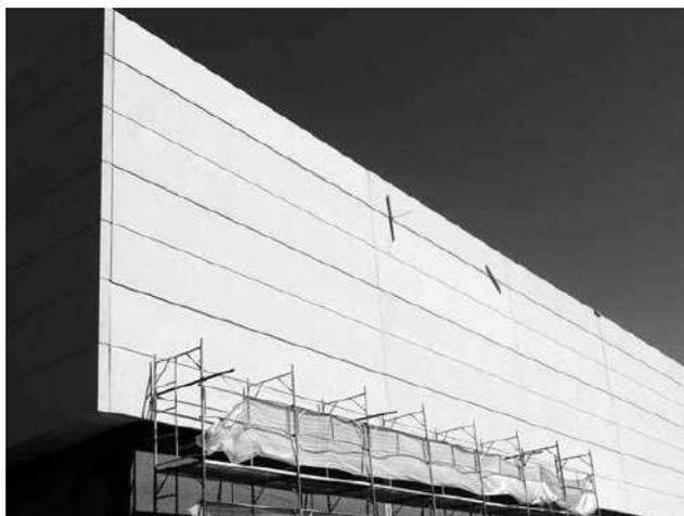
Figura 4.1 – Fechamento com painéis pré-fabricados de concreto. (Acervo INOVATEC CONSULTORES)
