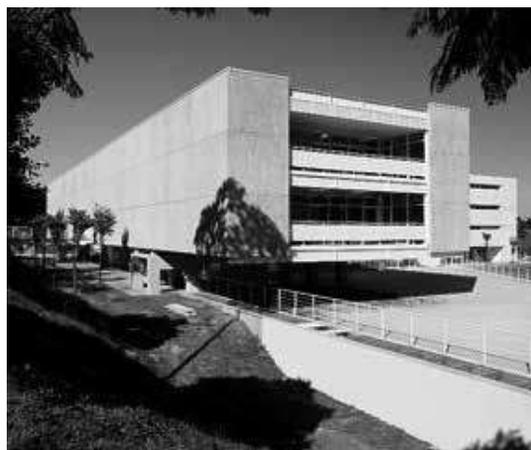
Figura 4.8 – Edifício da biblioteca central da PUC, em Campinas. Uso de painéis pré-fabricados para fechamento de edificação em estrutura metálica de aço. (foto Bebete Viegas. Projeto Arquitetura Piratininga Arquitetos Associados PAA)
