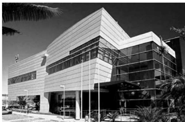
Figura 3.8 – Fachada de edifício comercial composta por painéis metálicos isolantes e vidros. (FINESTRA, 2004)
