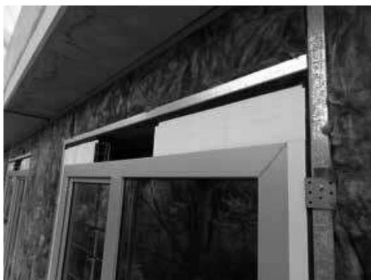
Figura 2.4 – Detalhe da vedação com LSF do tipo embutida (entre lajes) ainda sem os painéis de fechamento, mostrando o uso da lã mineral. (Acervo Inovatec Consultores)
