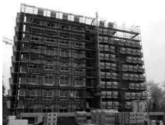
Figura 2.2 – Fachada de edifício residencial em construção com sistema de LSF e placas cimentícias. (Acervo Inovatec Consultores)
